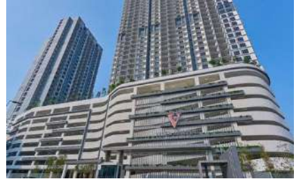
PV Vista Sentul
