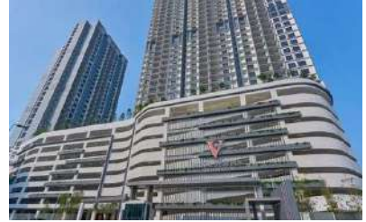
PV Vista Sentul
