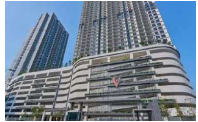
PV Vista Sentul
